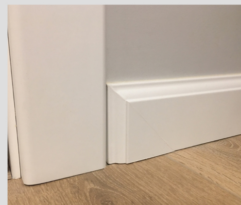
пример стыка наличника и плинтуса
