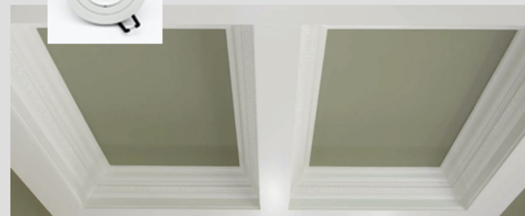
Оформление кессонов карнизом + покраска внутри кессонов+ закарнизная подсветка
