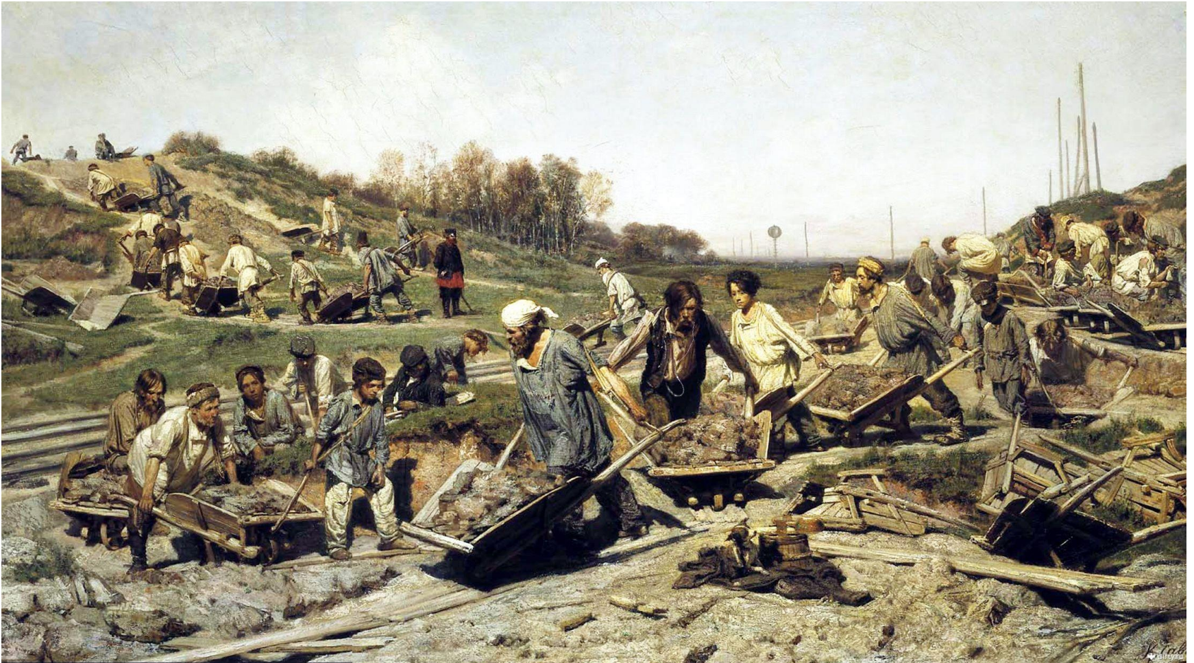
К.А. Савицкий. Ремонтные работы
