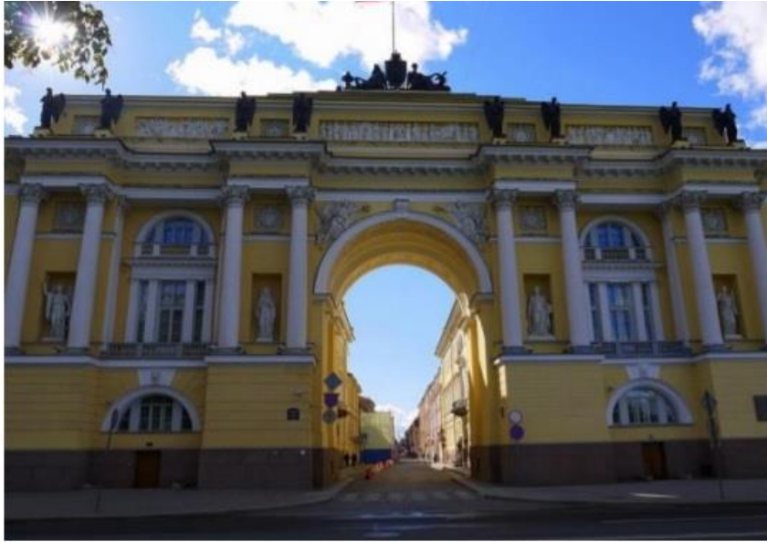
Здание Сената и Синода. Санкт-Петербург.
